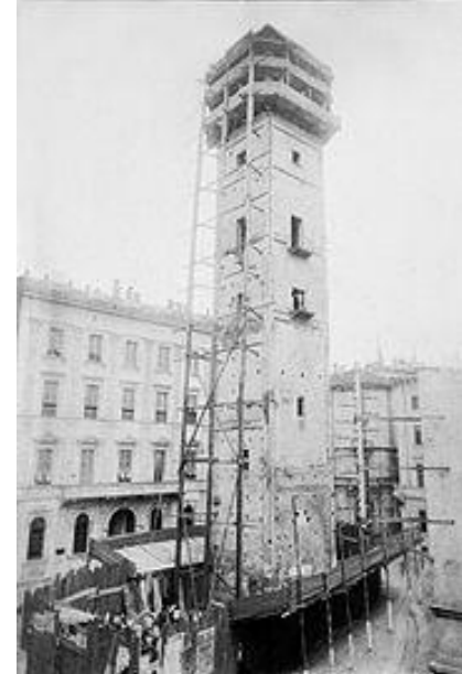
Campanile durante la demolizione
